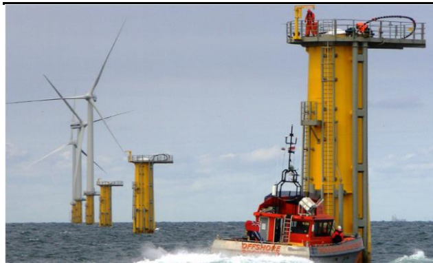
圖 56: 海上風電樁基，是海上風電項目其中一項核心
